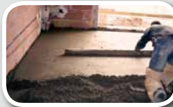
SOLERAS DE MORTERO
