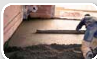
SOLERAS DE MORTERO
