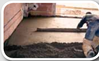
SOLERAS DE MORTERO
